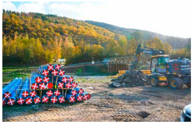
Das verwendete Rohrmaterial Polyethylen ist besonders widerstandsfähig und bietet damit hohen Schutz vor starken mechanischen Beschädigungen und langsamem Risswachstum. Die Druckrohre stellen damit eine äußerst sichere und langlebige Lösung beim Ausbau der Infrastruktur dar. Foto: SIMONA AG
