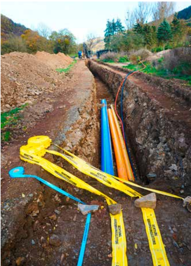
Bei den anstehenden Erneuerungen und Instandsetzungen wird die Infrastrukturtrasse mit weiteren Leitungen versehen. Neben Trinkwasser- und Abwasserdruckrohren werden auch Leerrohre für den Ausbau der Glasfaserversorgung sowie Gashochdruck- und Gasmittelhochdruckleitungen eingebaut. Foto: SIMONA AG
