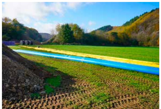
Die PE 100-RCLine SPC Trinkwasserdruckrohre und die Gasdruckrohre sind mit einem zusätzlichen äußeren Schutzmantel aus modifiziertem Polypropylen ausgestattet. Dieser schützt das innenliegende PE 100-RC Rohr vor mechanischen Beschädigungen – wie Kerben, Abrieb und Verschleiß. Foto: SIMONA AG
